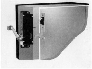
2-SE CIERRA LA PUERTA, EL PERNO CENTRADOR MARCA EL LUGAR DONDE VA FIJADO EL PRIMER TORNILLO DE LA **TRABA**
